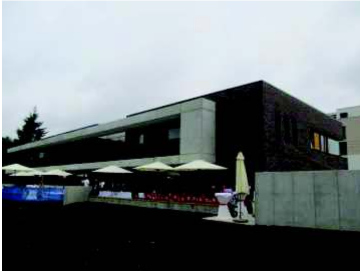
Frankfurti bölcsőde, óvoda Építész: Prof. Dr. Zimmermann és munkatársai, 2012 Szakértő: Sariri-Baffia Enikő Forrás: Tervezők
