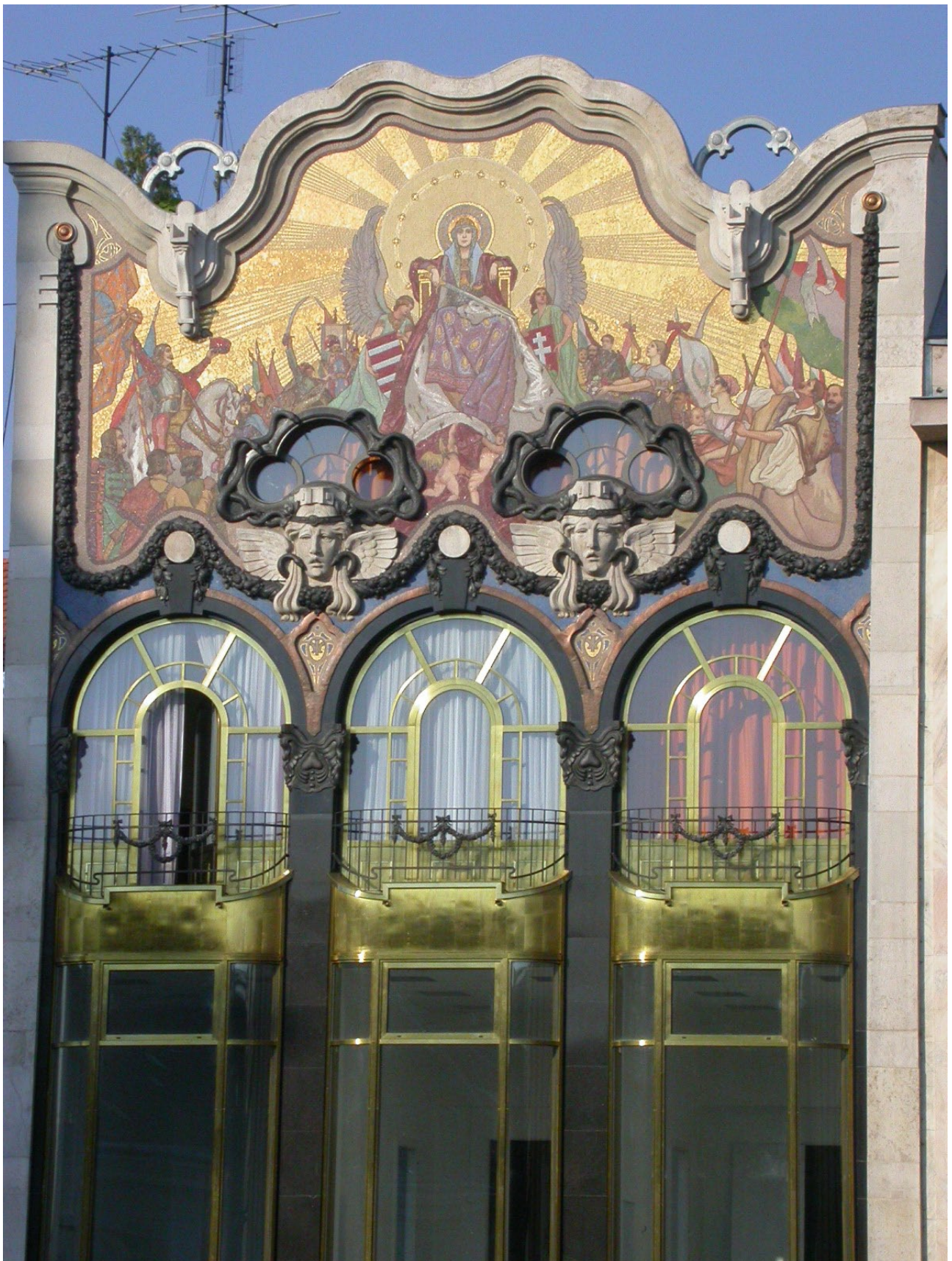
Budapest, V., Szervita tér 3. számú épület - volt Török Bankház - homlokzati rekonstrukciója. Patrona Hungariae homlokzati mozaikkompozíció - Róth Miksa műhely, 1906. Restaurálás utáni állapot, 2008.
