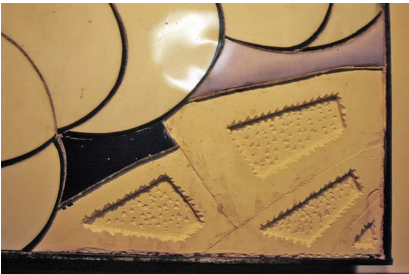
A leesett üvegelemek alatti gipszágyazatot kimélyítése a visszaépítéshez
