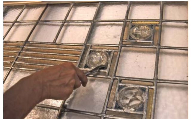
Rekonstruált üvegbetétek visszaépítése
