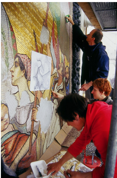
A restaurálás munkafolyamatai - a beépítésre kirakott, gézre felragasztott felület - beépítés - restaurált, rekonstruált mozaikrészek
