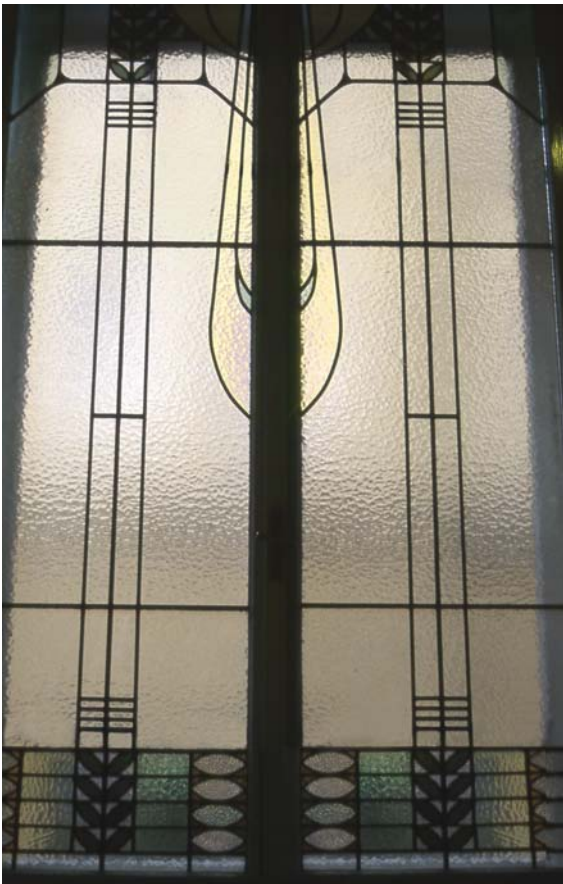
Ablak sorosan kötött mértani szerkesztésben, nagyfelületű üvegelemekkel
