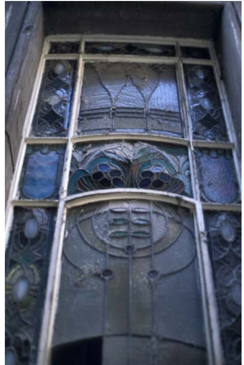
Háborús bombatámadás okozta felületi deformációk
