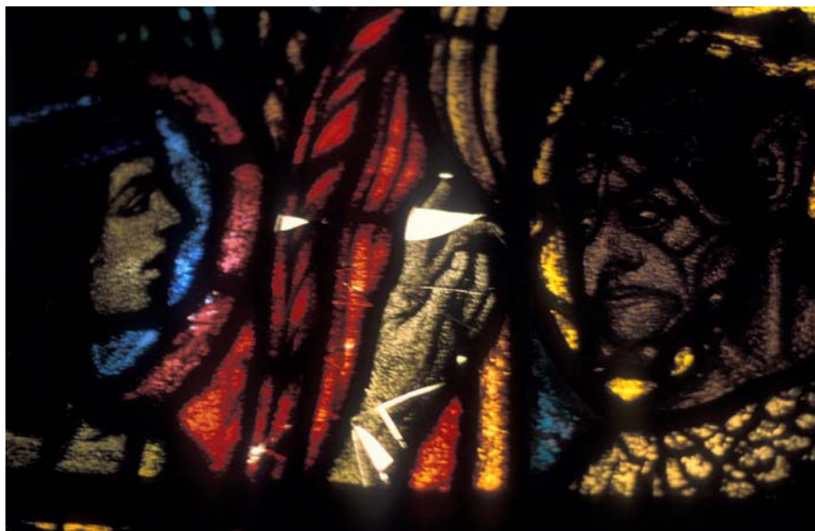
Az üvegfelületbe belenőtt faágak által okozott üvegtörések
