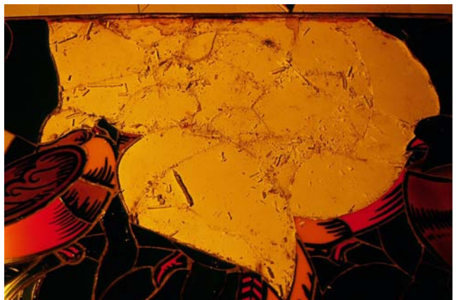
Az üvegtér gipszágyazattól elvált részei - a felületből kiemelt, elvált üvegszemek - gipszágyazat
