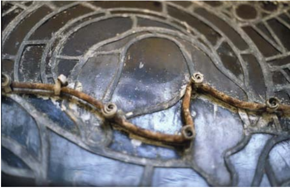
Erősen korrodálódott merevítővas
