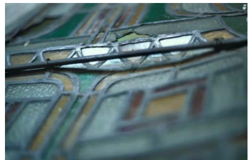
Ólmozott mező felületi deformációja
