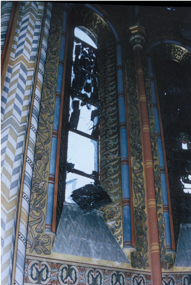
Bombamerényletben károsodott üvegfestmény
