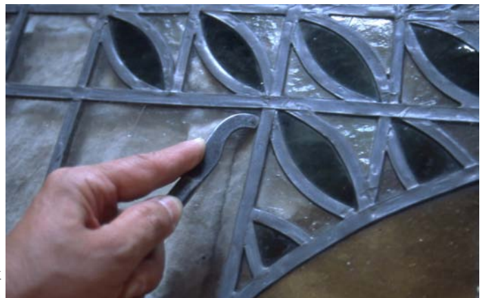
Letisztított üvegfelület, ólomsínek lesimítása tisztítás után
