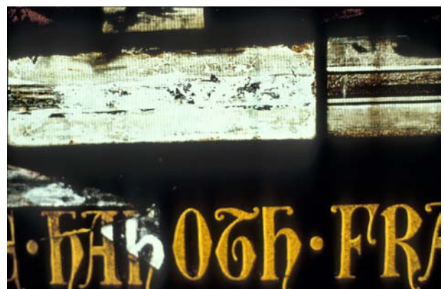
Lepergett festékrétegek, helytelen üvegpótlás
