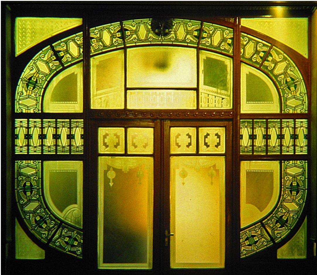
Töbttónusú savmaratás, gazdagon díszített bordúrral, fazettacsiszolt betétekkel, Liszt Ferenc Zeneakadémia
