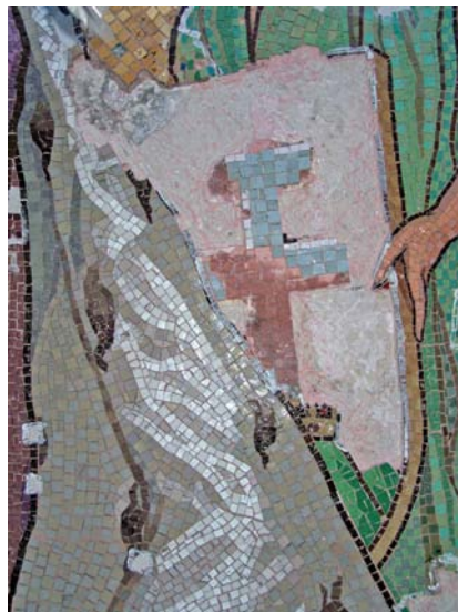
A két címerpajzs rekonstrukciója, a kivésett felületekkel - beépítés közben - az elkészült árpádsávos és kettőskeresztes pajzsok, a beépítés után
