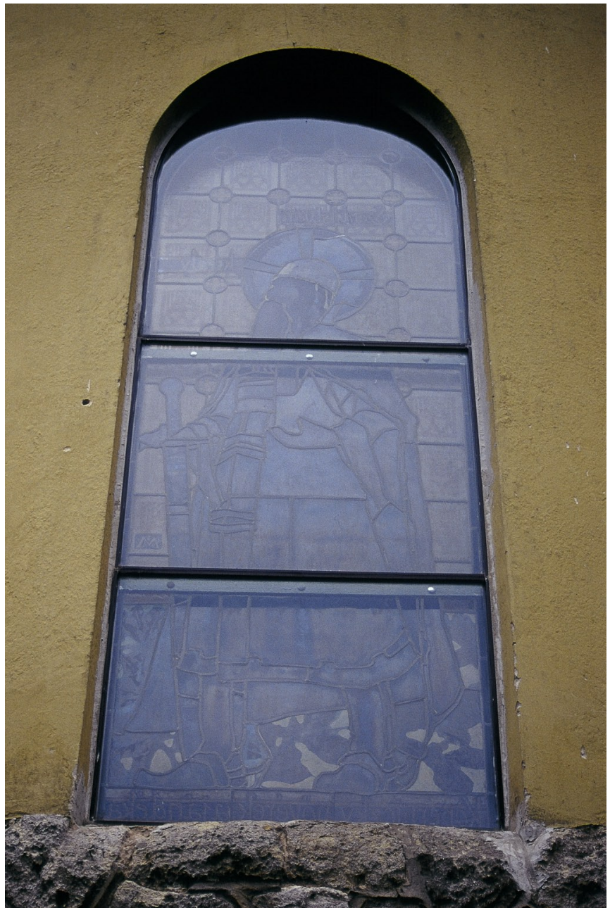
Ólmozott üveablak elé épített védőüvegezés
