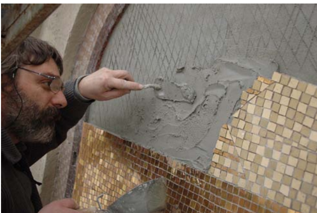
Aranysugarak restaurálási munkafolyamatai - háborús belövések után pontatlanul, rossz anyaggal pótolta részek - kivésott felületek - a hiányzó, kirakott részek ellenőrzése műtermi körülmények között - kirakott részek beépítése ágyazóhabarcsba - felület előkészítése beépítésre - restaurált, rekonstruált sugarak
