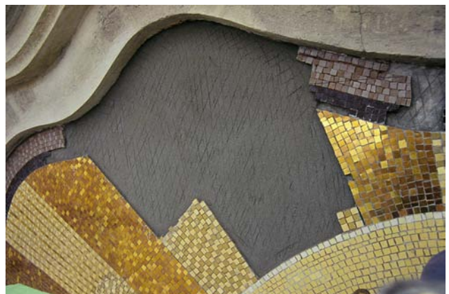
Aranysugarak restaurálási munkafolyamatai - háborús belövések után pontatlanul, rossz anyaggal pótolta részek - kivésott felületek - a hiányzó, kirakott részek ellenőrzése műtermi körülmények között - kirakott részek beépítése ágyazóhabarcsba - felület előkészítése beépítésre - restaurált, rekonstruált sugarak
