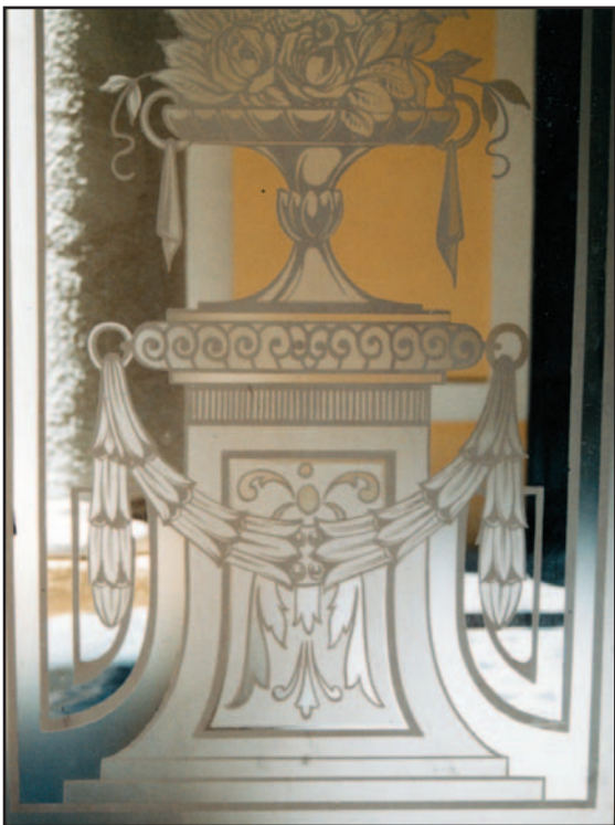
Baross utca 41. lakóház, Budapest VIII. - lépcsőház, többtónusú savmaratással készített ajtóbetétek rekonstrukciója - vektorizált kartonrajz
