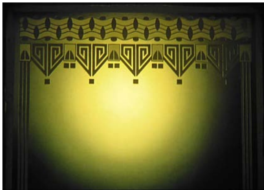
Töbttónusú savmaratás, gazdagon díszített bordúrral, fazettacsiszolt betétekkel, Liszt Ferenc Zeneakadémia
