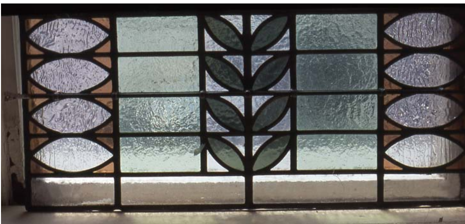
Sorosan kötött minták, az ablakok legalsó részéből, amelyek harmonikaszzerűen csuklottak össze a fölöttük lévő üvegfelületek nagy súlya alatt - már restaurált üvegfelület
