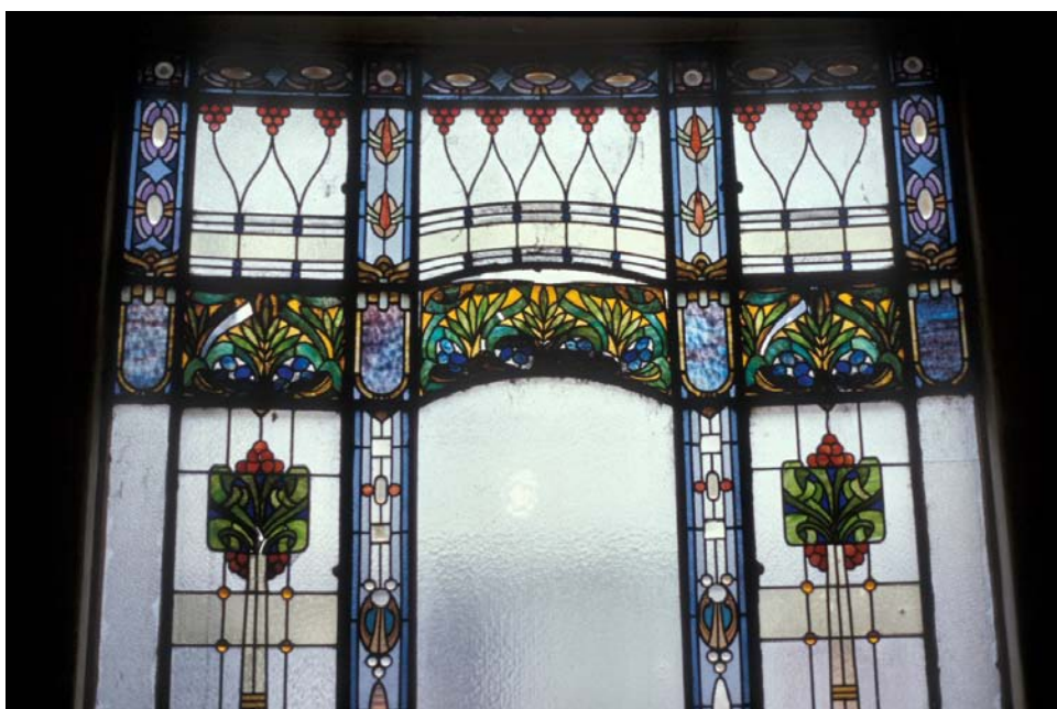
Háborús bombatámadás következtében kiesett üvegmezők
