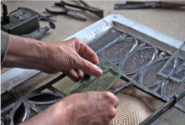
Hiányzó, törött, nem megfelelő színű és texturájú üvegek pótlása
