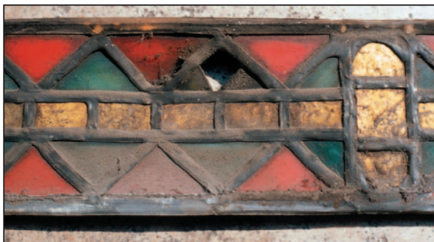
Vas utcai iskola, Budapest VIII. – homlokzat díszüvegezésének restaurálása
