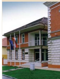
34. ábra A tamási Ügyészség épülete a főút felől.
