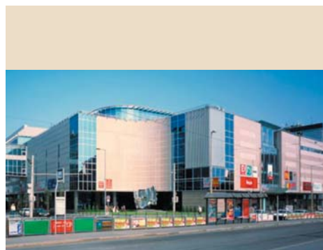
17. ábra Az épület homlokzata elegáns rózsaszín gránit és kékes üveg függönyfal. Erre vannak szerelve a világító reklámfeliratok és plakátok.
