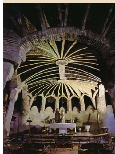
4. ábra A Colónia Güell kriptája ferde bazalt oszlopokkal, egyedi boltozatokkal.
