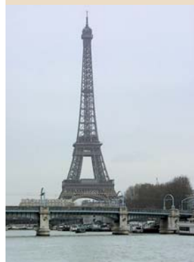
5. ábra A párizsi Eiffel torony az 1889. évi Világkiállításra épült. Sokáig a legmagasabb épület volt a világon (300 m.) A tervező és építővállalat vezetője Gustave Eiffel volt.
