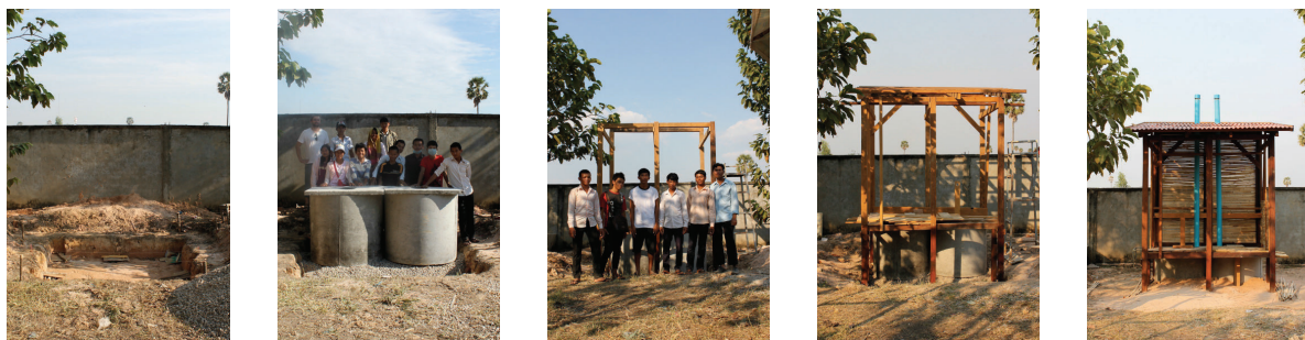
134-138. képek: fotók az építés stádiumairól
