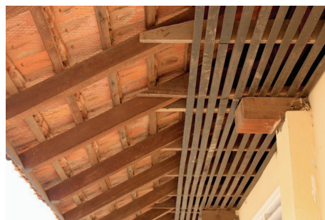
105-107. képek balról jobbra: gerincek kiszellőzése; üveglamellás nyílászáró felső szellőző nyílással; ereszes beszellőzése Nemzeti Mezőgazdasági Iskola, Kambodzsa, Kampong Cham, Reischl Gábor, 1989-91
