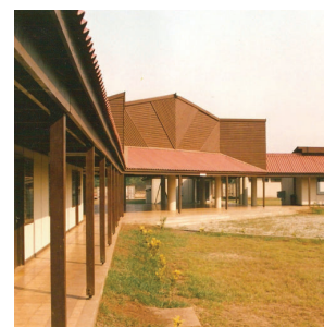
79. kép: a főépület
