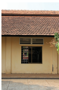
105-107. képek balról jobbra: gerincek kiszellőzése; üveglamellás nyílászáró felső szellőző nyílással; ereszes beszellőzése Nemzeti Mezőgazdasági Iskola, Kambodzsa, Kampong Cham, Reischl Gábor, 1989-91
