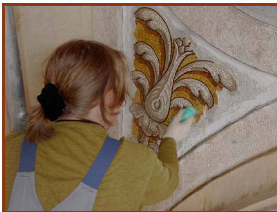
A mozaik mélyebb rétegeinek megszilárdítása injektálásos módszerrel.
