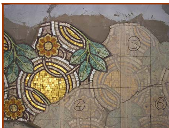
Homokágyba rakott, ideiglenesen gézre ragasztott mozaik a beépítés közben.
