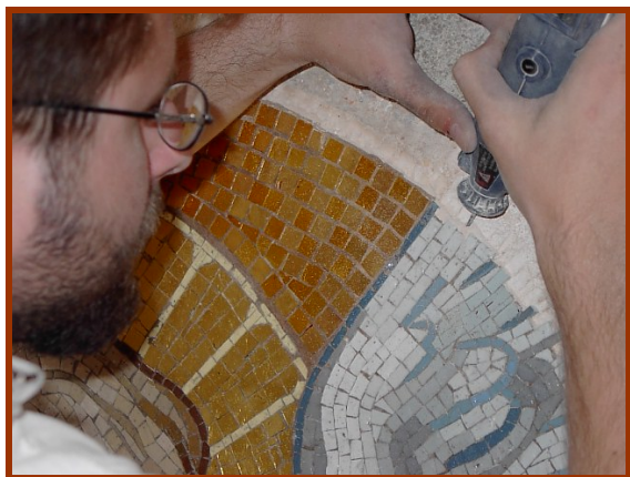
A mozaik mélyebb rétegeinek megszilárdítása injektálásos módszerrel.
