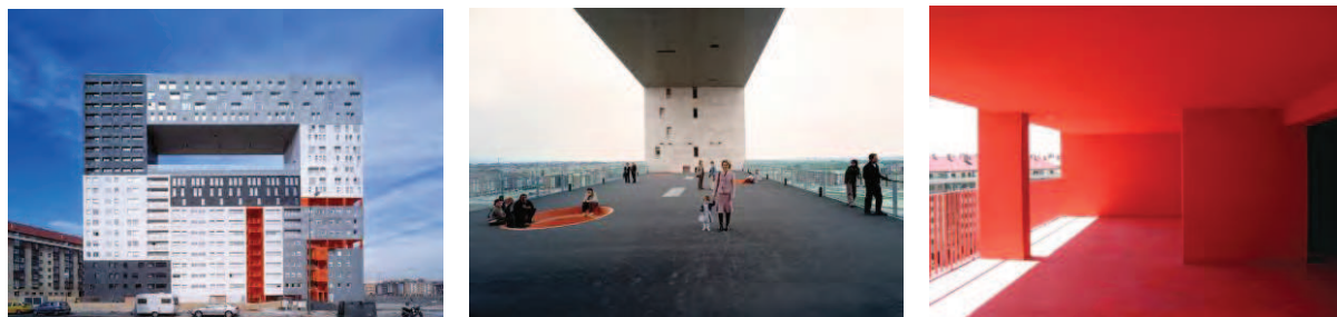
26/ MVRDV: Casa Mirador, Sanchinarro, Madrid, Sp. (2001-2012)
